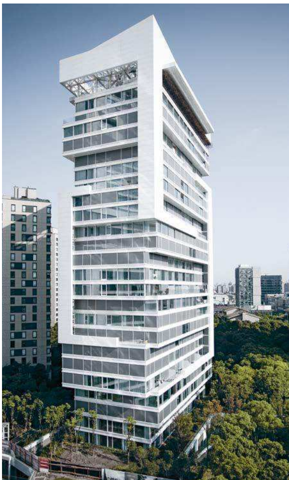
Schanghai, China Zwei Wohntürme mit Druck/Sog-Belastungen von 316 kg/m 2 . Höchstanforderungen an den Schallschutz durch die zentrale Lage.
